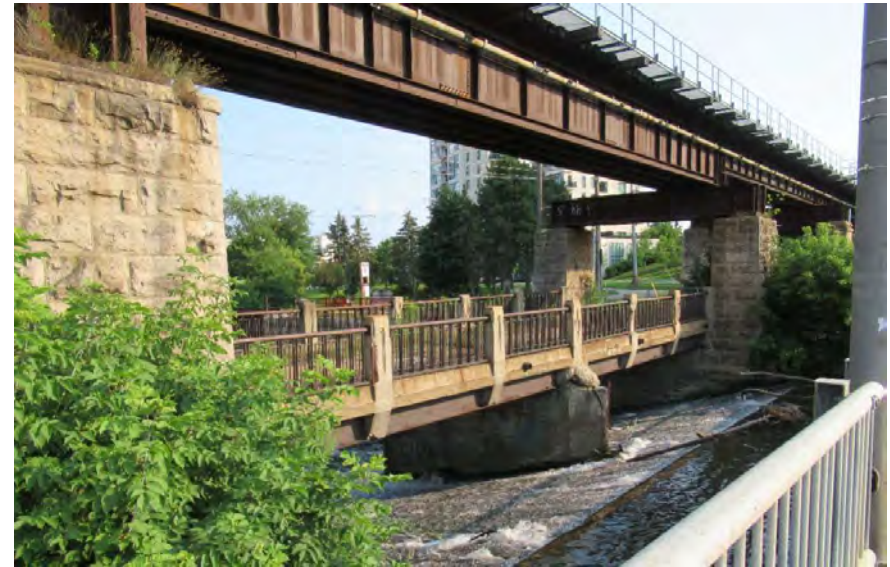
3a) Allans Dam Bridge
