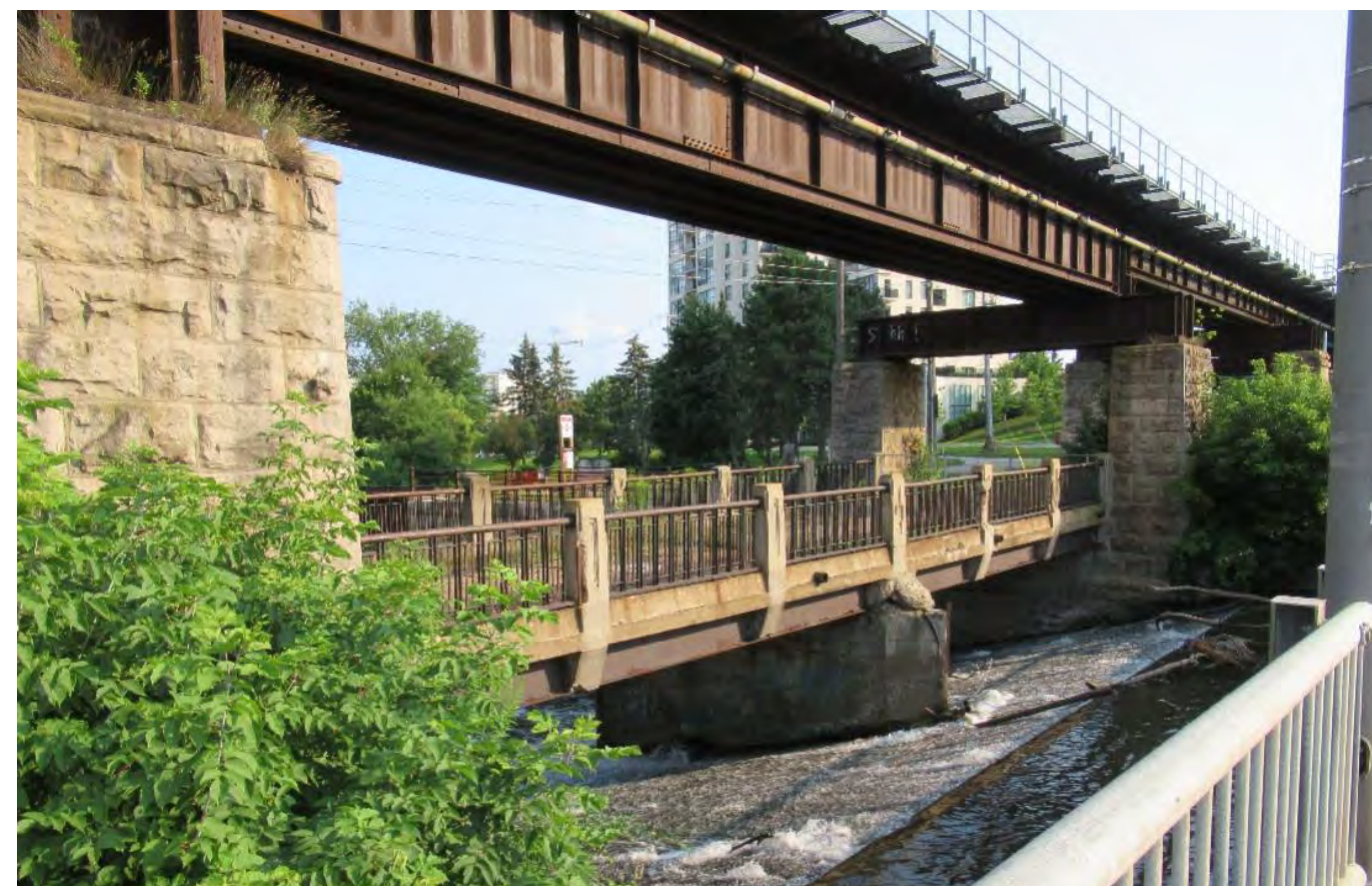
22a) Allans Dam Bridge
