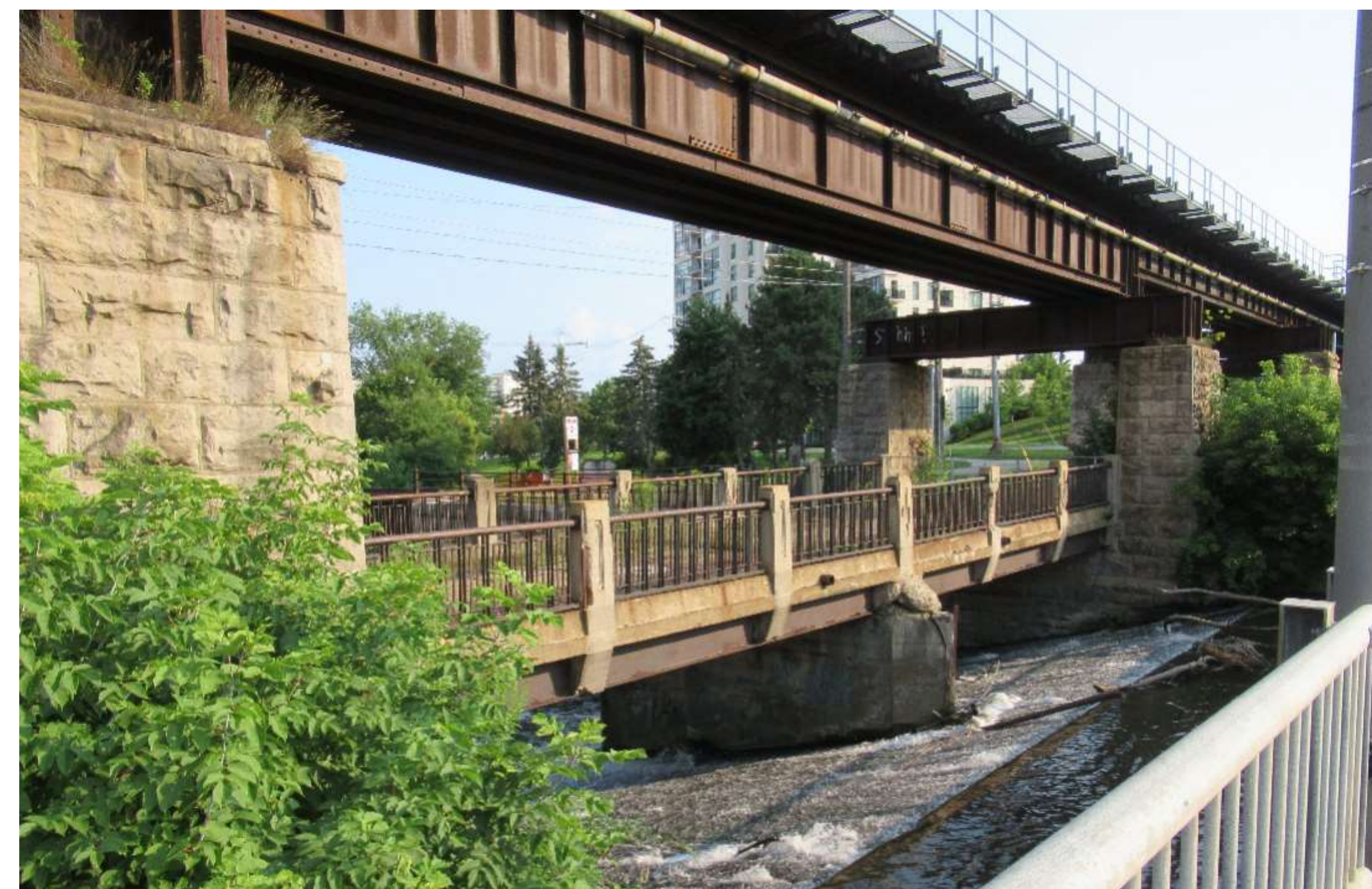
3a) Allans Dam Bridge
